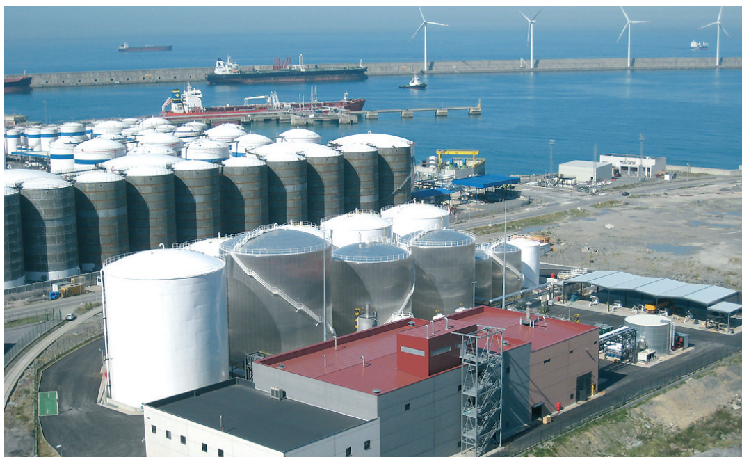
Biocombustibles de Zierbana está instalada en la zona industrial del Puerto de Bilbao
